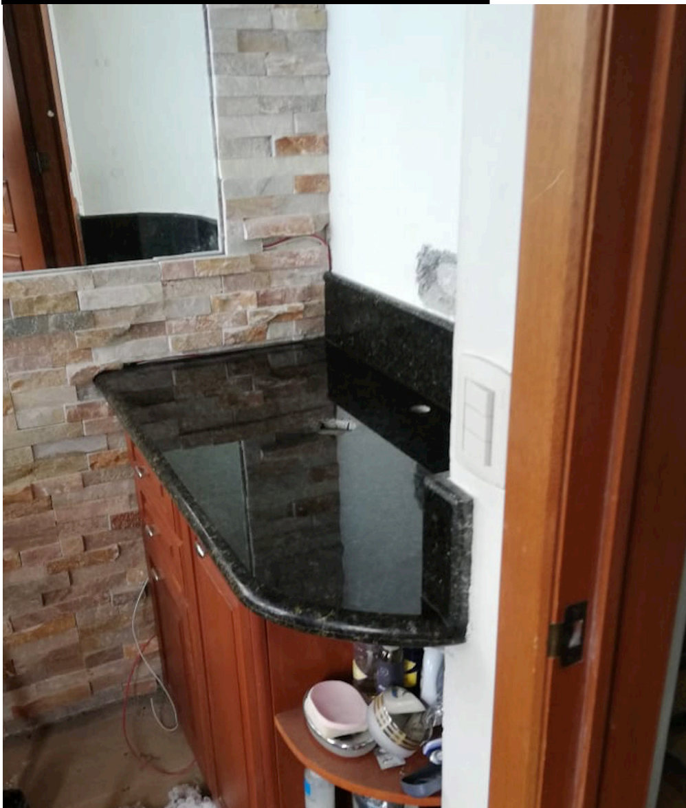
Granito Verde Ubatuba Instalación de top.
