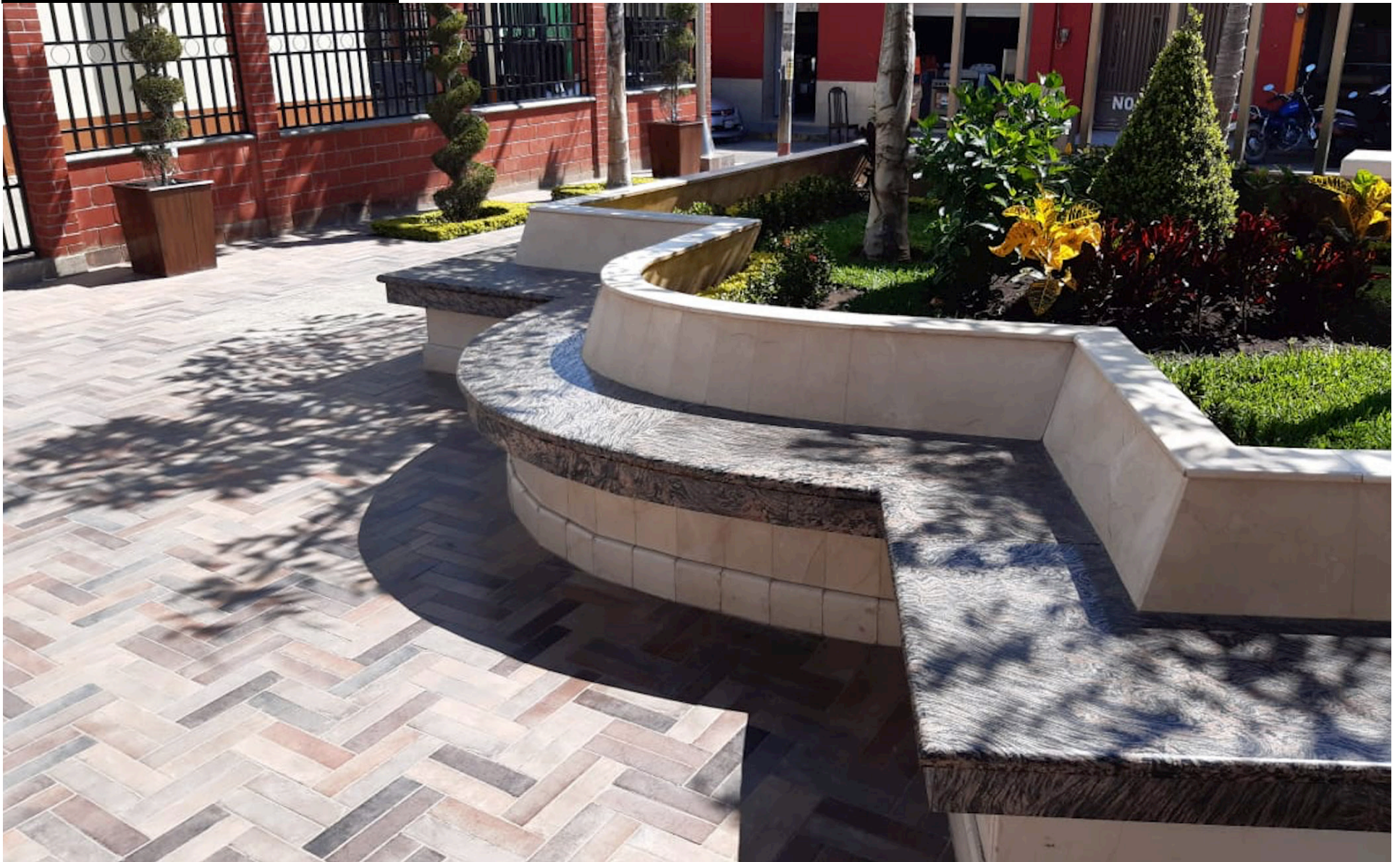
Granito Tiger Skin Instalación parque de Jutiapa.
