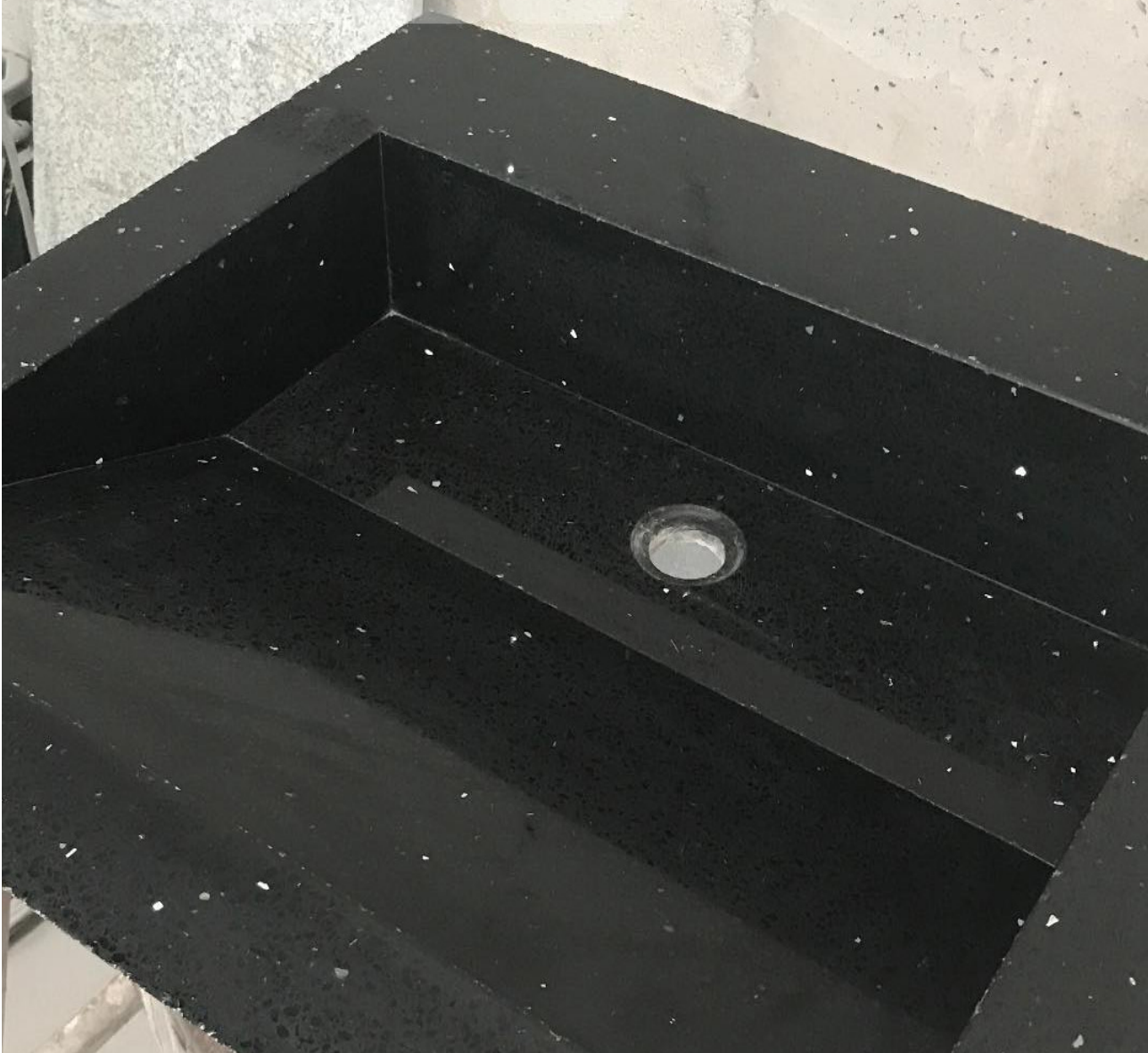
Cuarzo Negro Estelar Instalación tops de lavamanos (Starbucks Guatemala).
