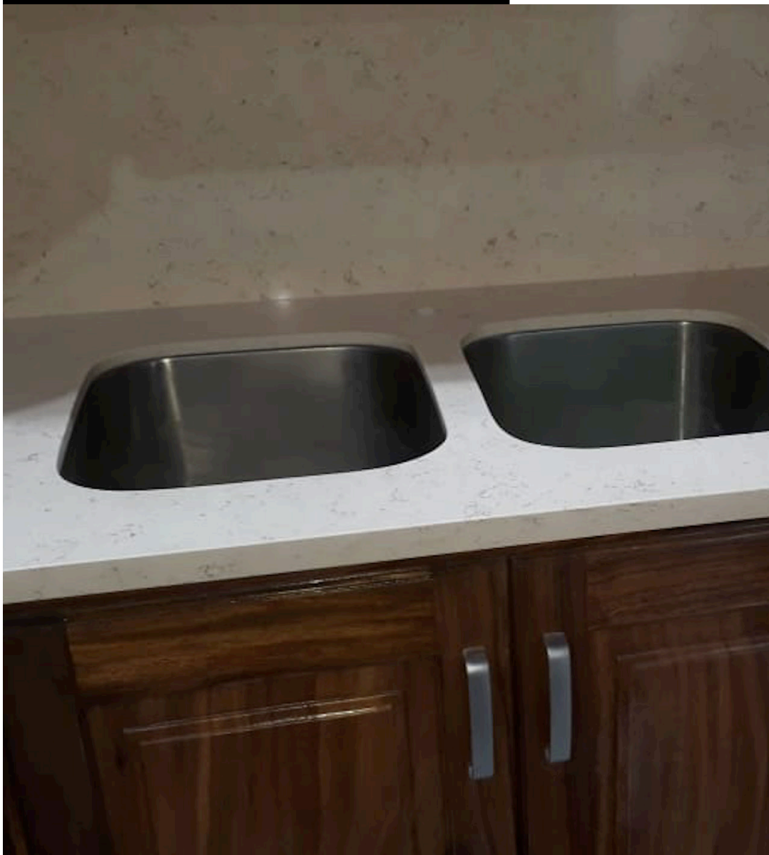
Cuarzo Phoenix Instalación top de cocina.
