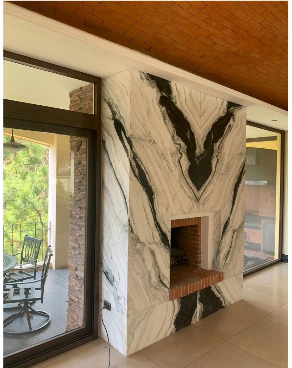
Mármol Panda Instalación chimenea.
