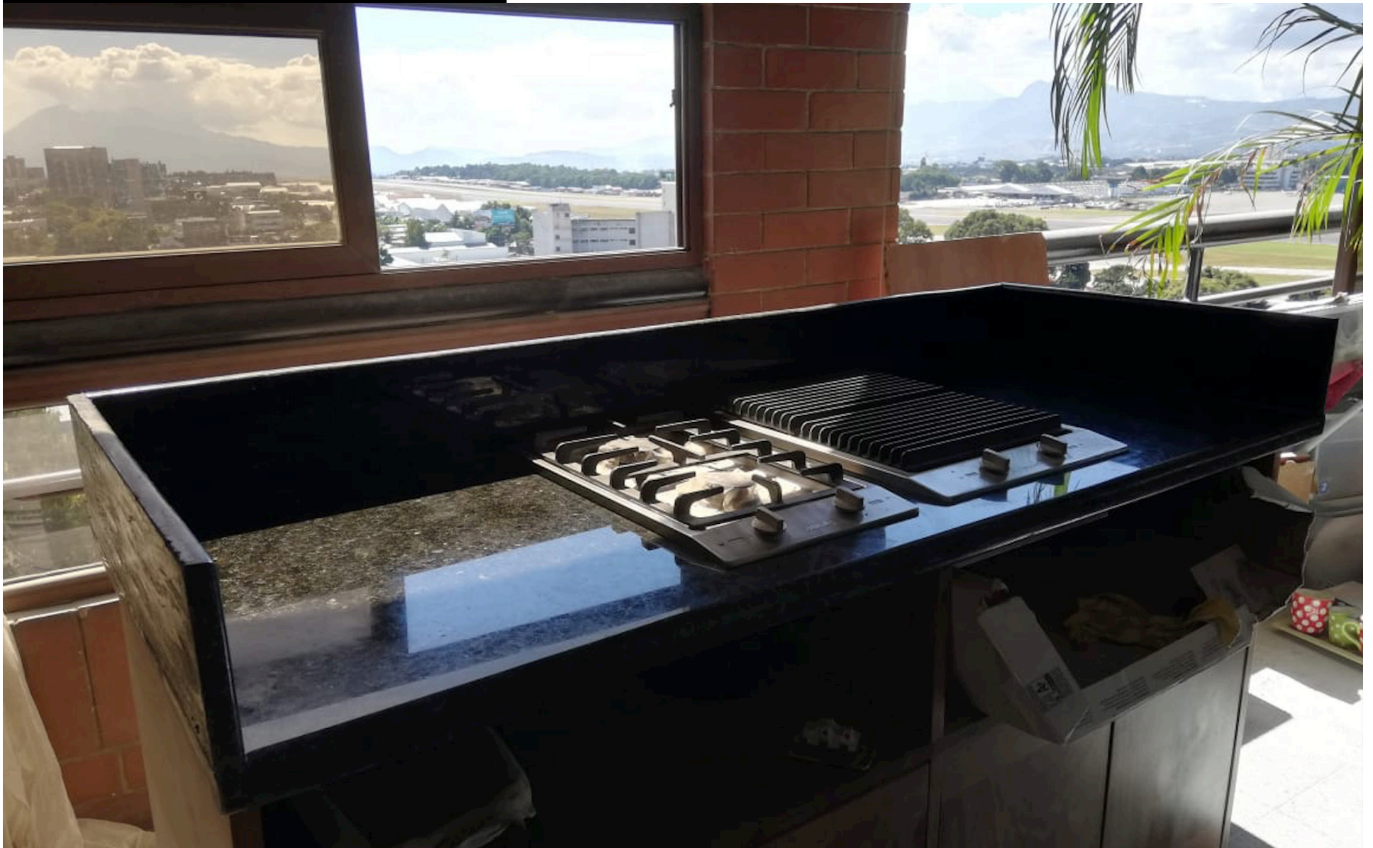
Granito Verde Ubatuba Instalación top de churrasquera.
