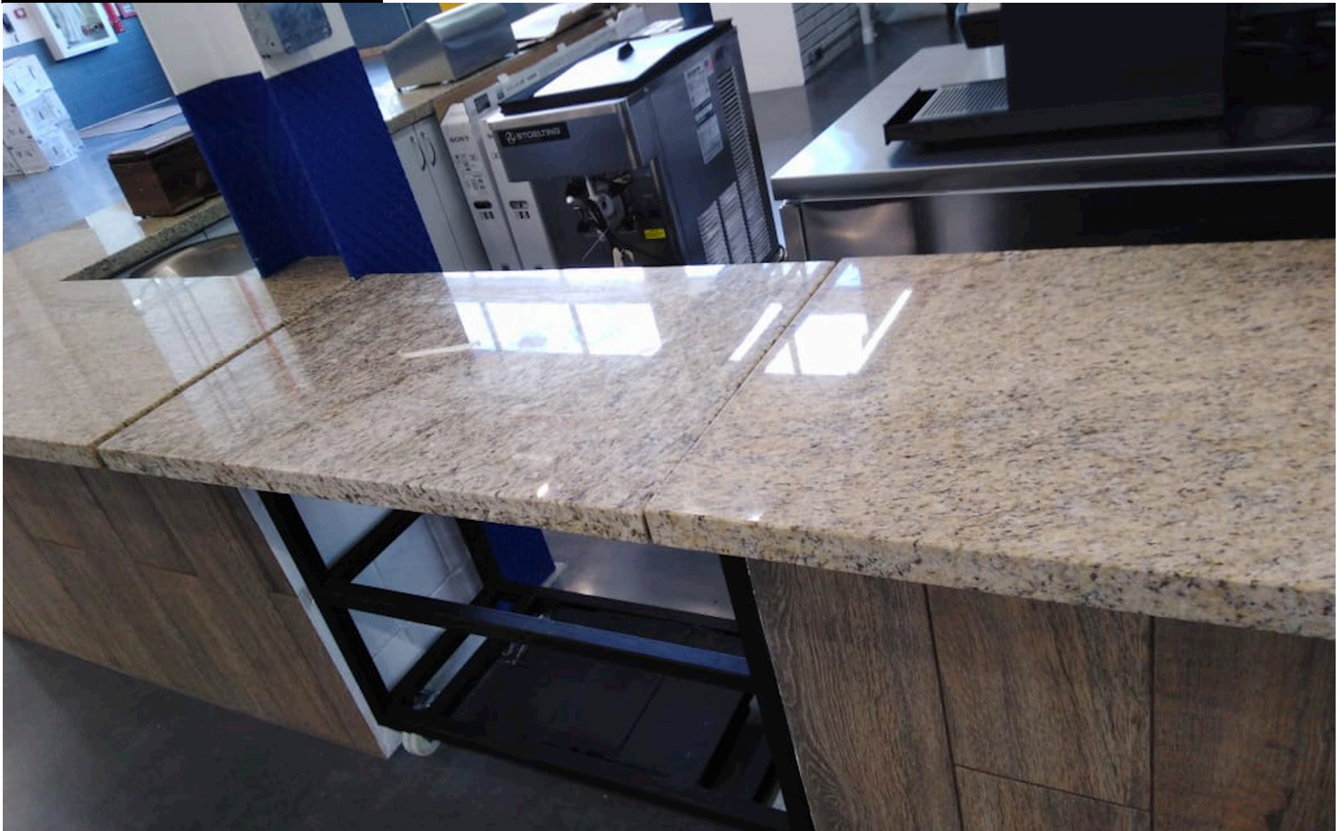
Granito Tan Brown Instalación de tops (Pricesmart San Cristóbal).
