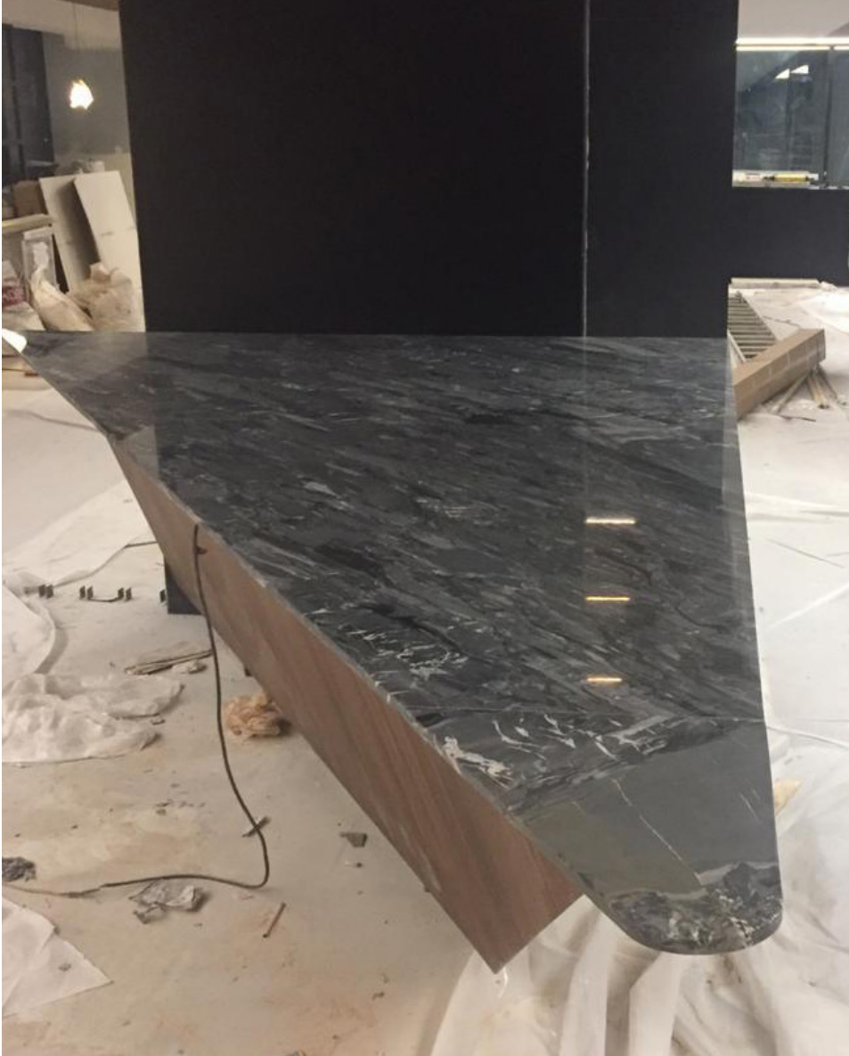
Mármol San Lorenzo Instalación de top (Zacapa Lounge, Aeropuerto Internacional La Aurora).
