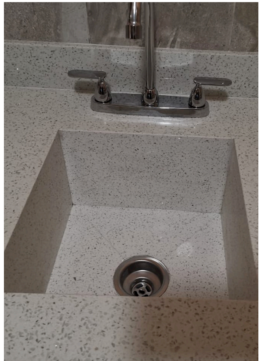
Cuarzo Blanco Estelar Instalación top de lavamanos.
