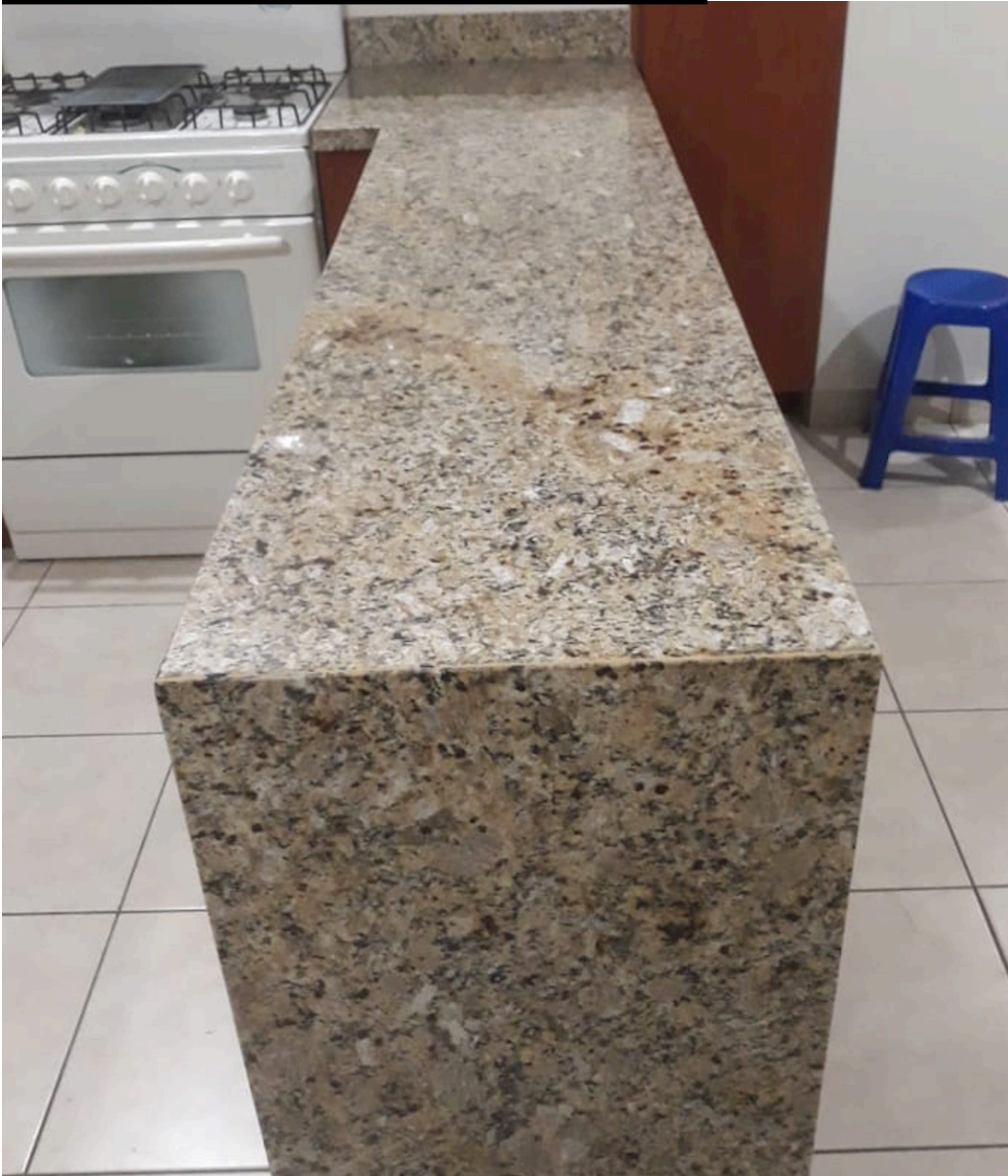
Granito Gold White Instalación top de cocina.
