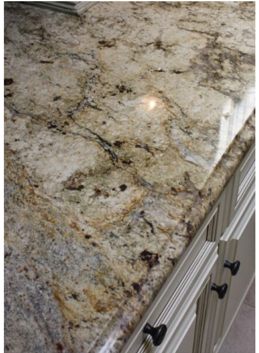
Granito New Venetian Gold Instalación top de cocina.
