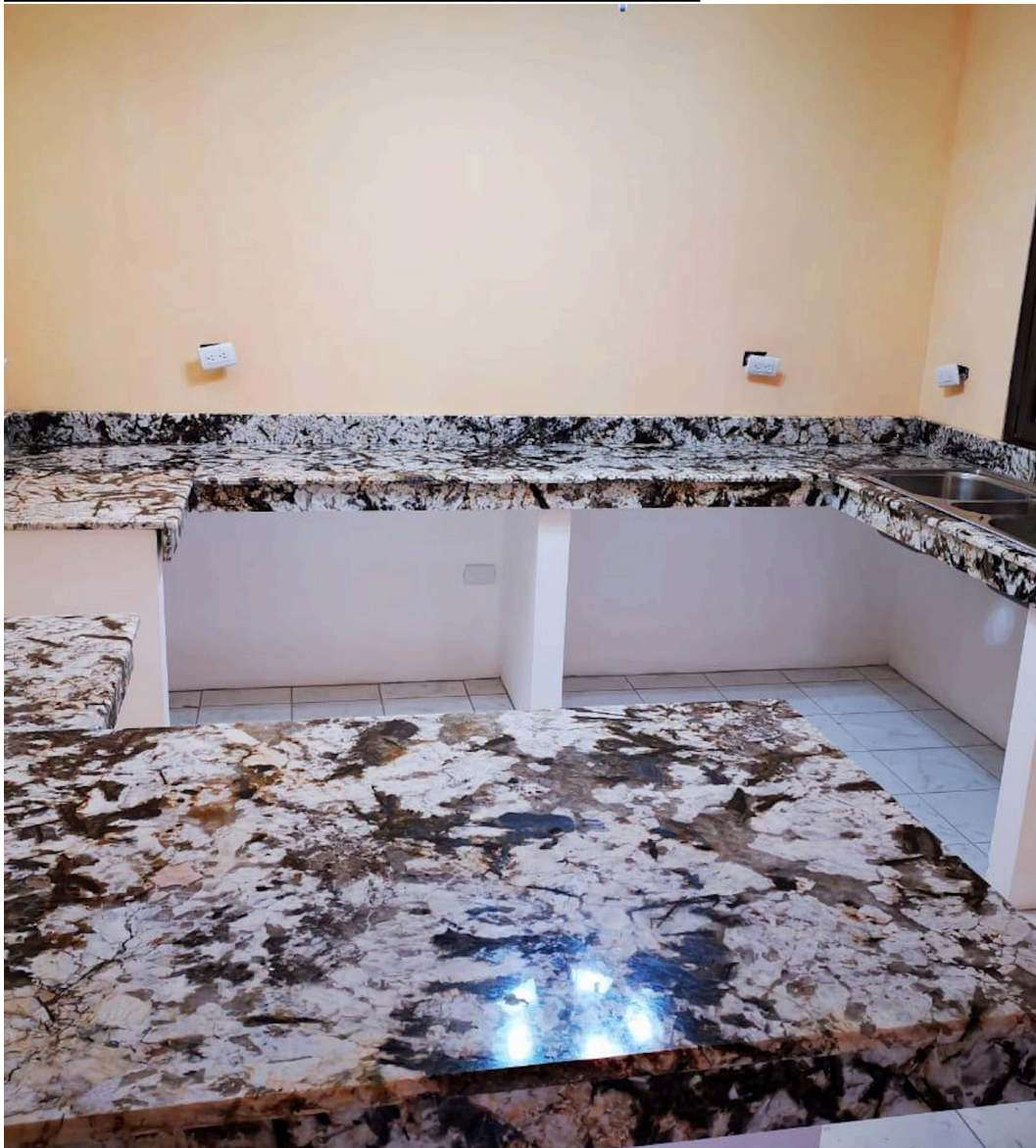
Granito Lapolina Instalación top de cocina.
