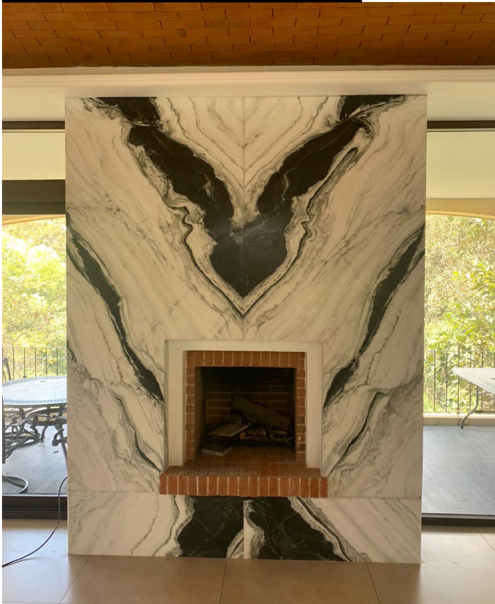
Mármol Panda Instalación chimenea.
