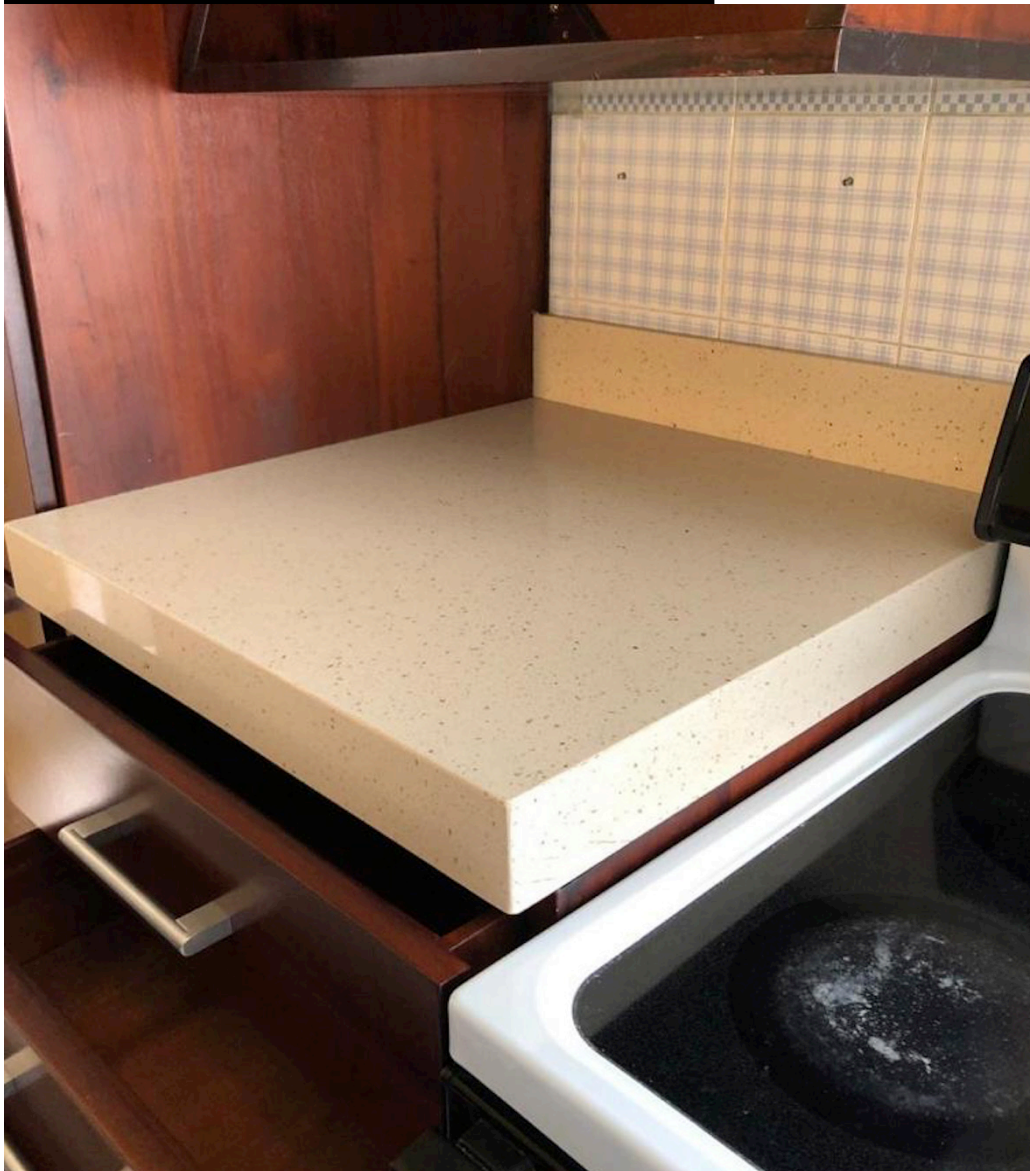
Cuarzo Beige Estelar Instalación top de cocina.
